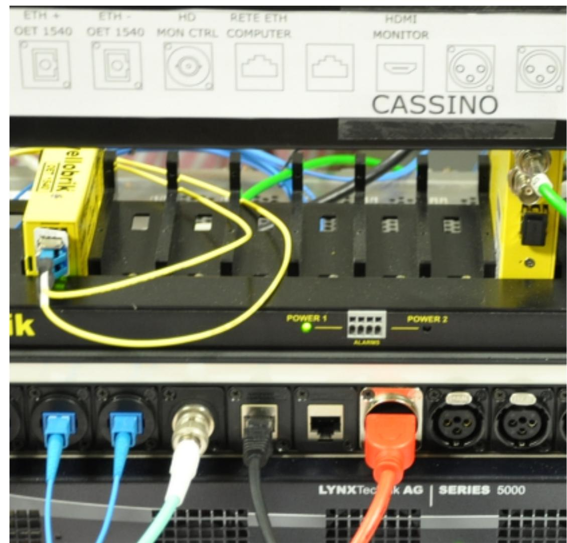
**Trasmissione di segnali Video e Audio ad altissima risoluzione e senza compressione tramite Extender su Fibra Ottica Spenta (no IP) per distanze superiori ai 10 Km**
